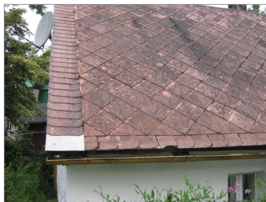
Fot. 2 Płyty azbestowo-cementowe płaskie
