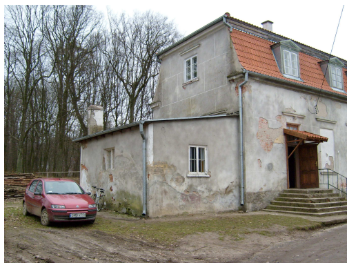
Fot. 9. Świetlica wiejska
