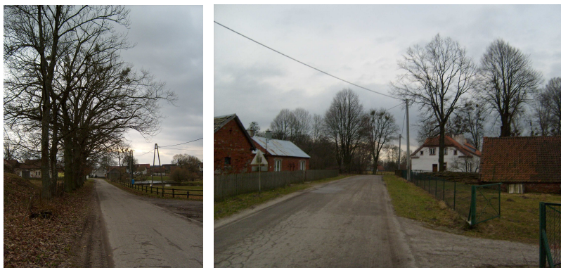
Fot. 13. Droga powiatowa Nr 1389
