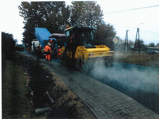
Układanie nowych warstw nawierzchni jezdni w ciągu dróg- poprawa warunków komunikacyjnych (nakładki)
