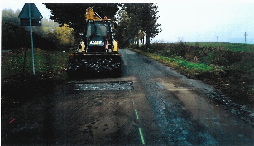
Frezowanie przed naprawą- układaniem nowej nawierzchni bitumicznej jezdni DP 1154N odc. Słobity
