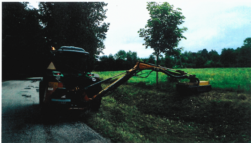
Poprawa widoczności na łukach dróg- usuwanie krzaków i chwastów
