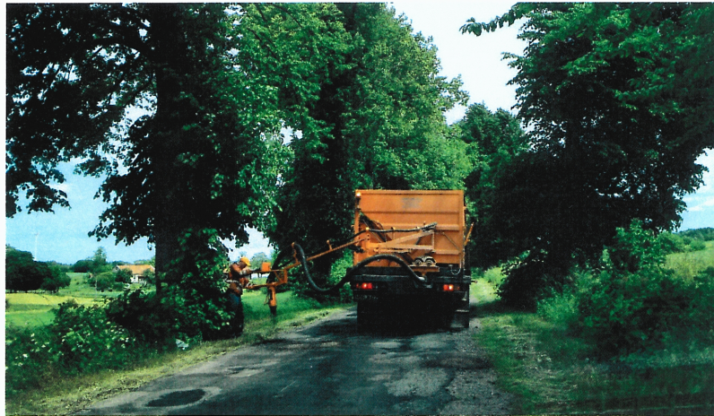
Remont, naprawa spękań i ubytków w jezdniach
