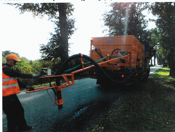
Bieżąca naprawa nawierzchni dróg powiatowych grysami i emulsją
