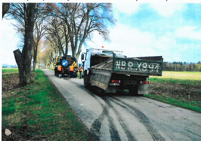
Naprawa ubytków w nawierzchniach bitumicznych grysami i emulsją
