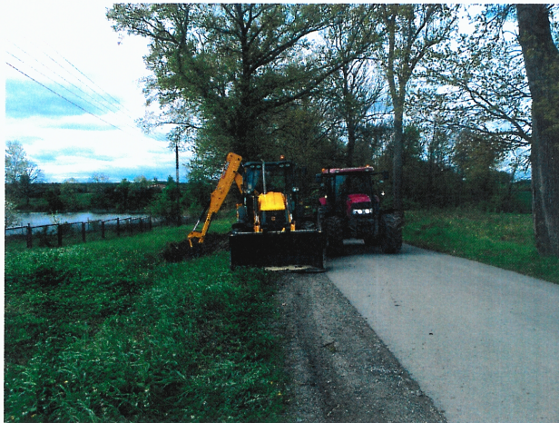
Poprawa odwodnienia jezdni- zbieranie zawyżonych poboczy i oczyszczanie rowów w Słobitach
