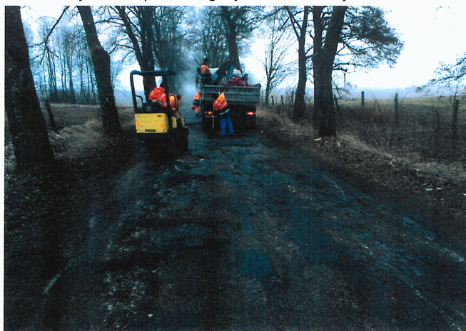
Bieżąca naprawa ubytków w nawierzchni masą bitumiczną na zimno
