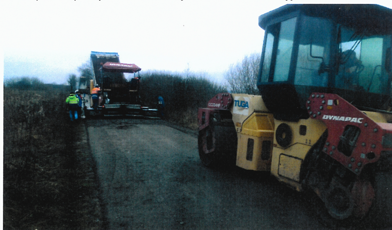
Naprawa przełomów w ciągu DP 1158N Karwiny- Osiek nawierzchnia z kruszywa
