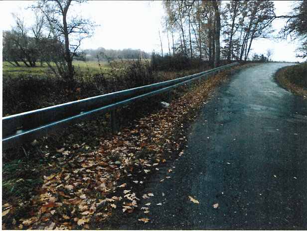
Montaż elementów bezpieczeństwa ruchu drogowego – stalowe bariery ochronne
