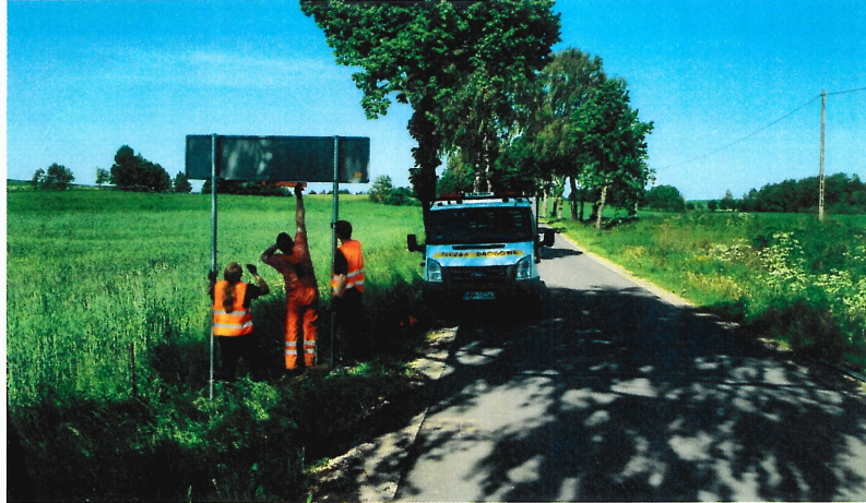
Ustawianie oznakowania pionowego w ramach stałej organizacji ruchu
