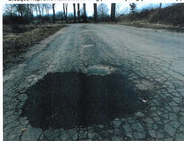
Remont ubytków w nawierzchniach jezdni masą bitumiczną na zimno
